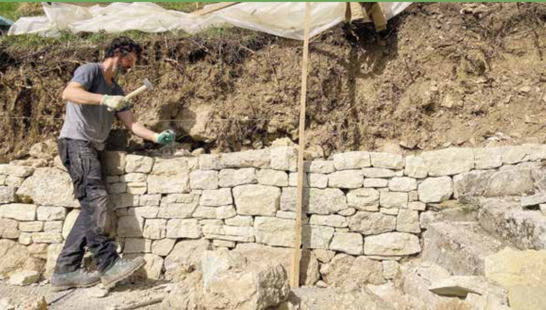
Die Instandsetzung der Rebbergmauern am Bielersee trägt zum Erosionsschutz bei und kommt Eidechsen, Wildbienen und verschiedenen Schmetterlingen zugute.
