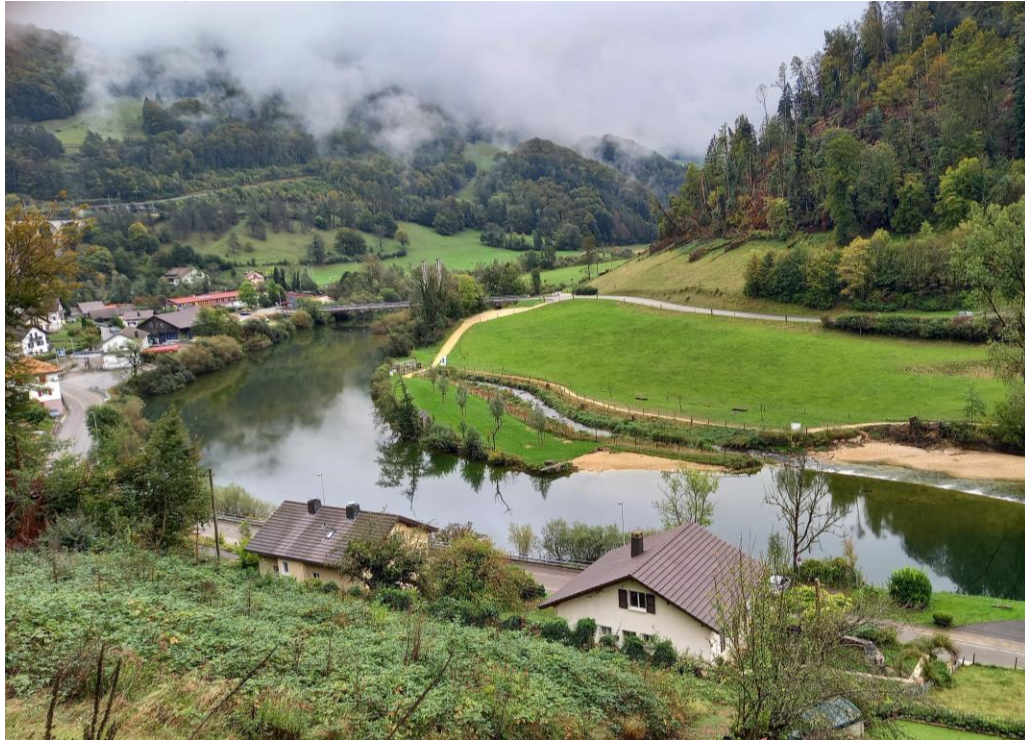
Exemple d'aménagement aux bords du Doubs (2019) : ruisseau de contournement et aire de détente
