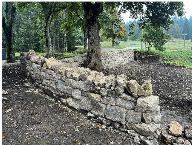
Légende : restauration de murs de soutènement et à double parement effectuée dans le secteur de l'Aurore en 2025 (© Parc Chasseral).
