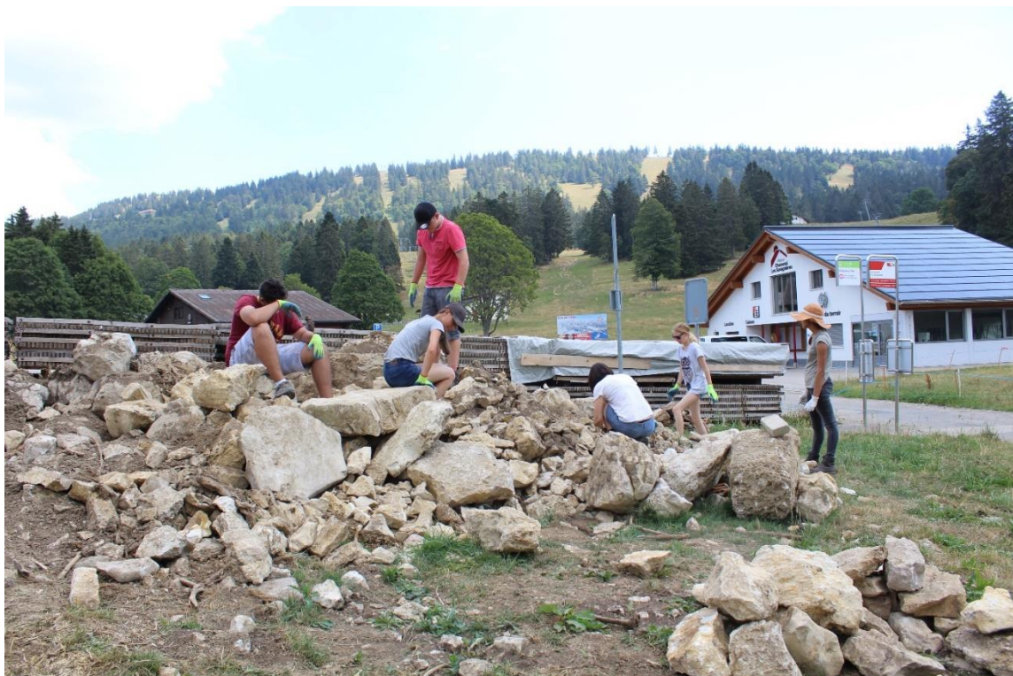
Légende : Des élèves trient des pierres, qui seront ensuite utilisées dans la rénovation de murs en pierres sèches © Parc Chasseral
