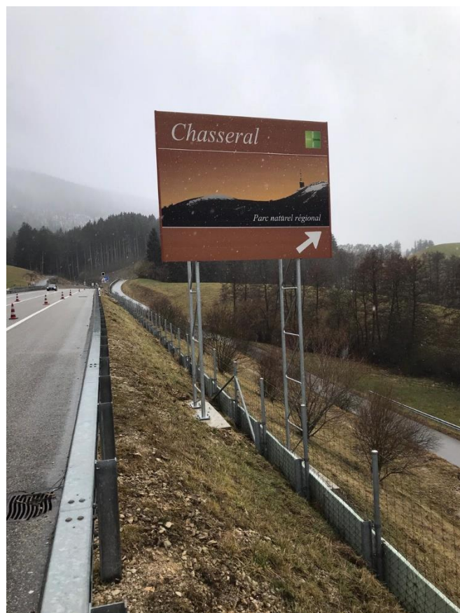
Panneau installé sur l'A16, à Reconvilier (BE) © Signal SA
