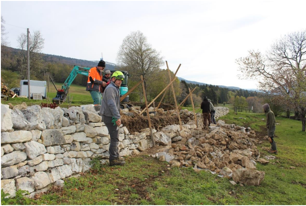
Légende : Les apprentis muretiers sur le dernier tronçon à rénover du mur en pierres sèches de La Mayette, à Lignières, en mai 2019. © Parc Chasseral
